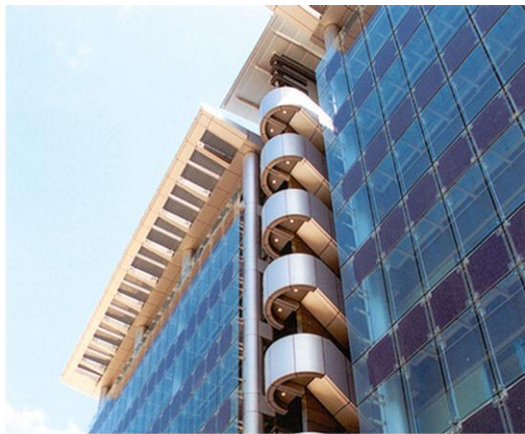
รูปที่ 4.12 แผงเซลล์แสงอาทิตย์ถูกใช้แทนผนังอาคาร (ซ้าย) และหลังคา
