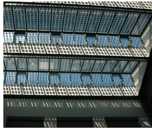
รูปที่ 4.12 แผงเซลล์แสงอาทิตย์ถูกใช้แทนผนังอาคาร (ซ้าย) และหลังคา
